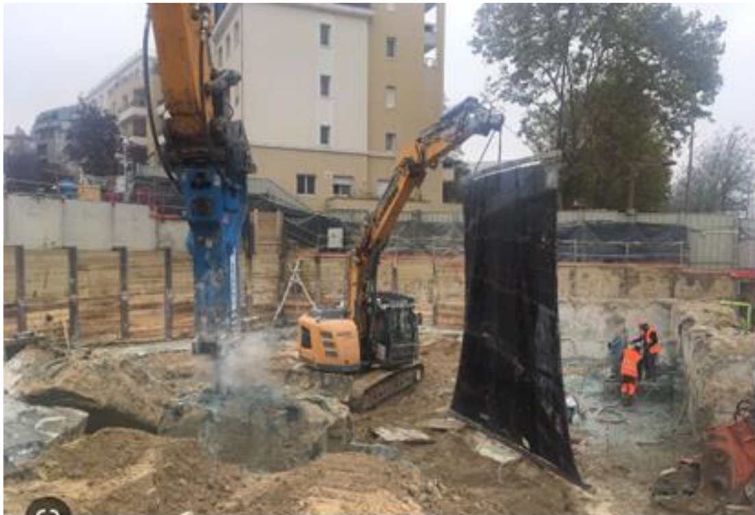
Figure 2. Exemple de bâches suspendues au droit des démolitions
